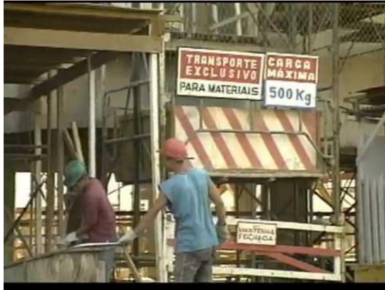
Figura 03 – Exemplo de dispositivo usado no transporte de materiais muito comum em obras verticais.
