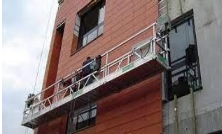
Figura 08 – Aplicação de andaimes em balanço.
