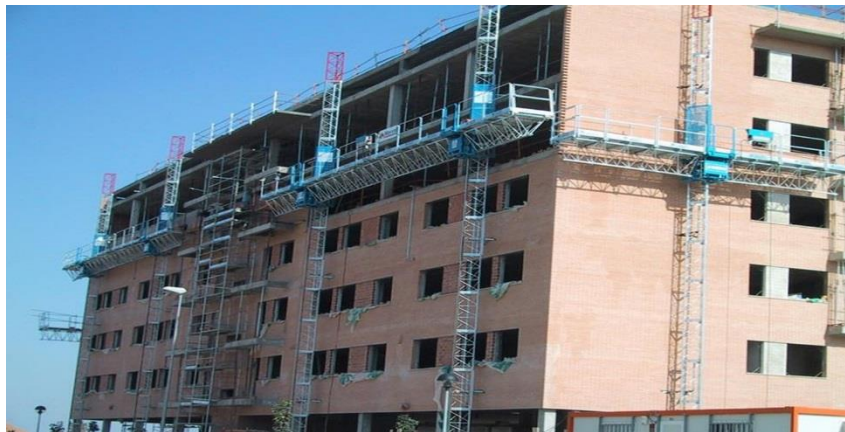
Figura 01 – Exemplo de elevadores utilizados em obras verticais.
