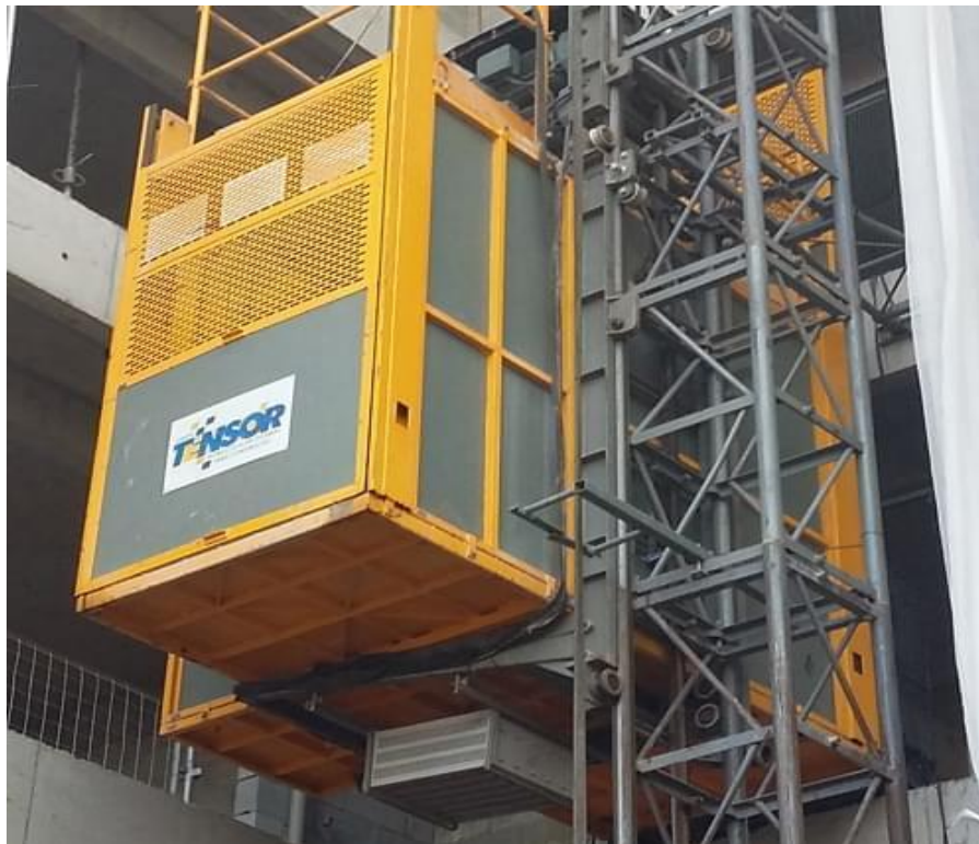
Figura 02 – Torre de elevador do tipo cremalheira.
