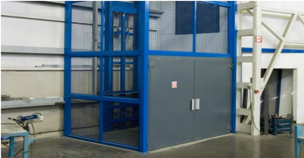
Figura 04 – Exemplo de elevador usado no transporte de pessoas nas obras verticais.
