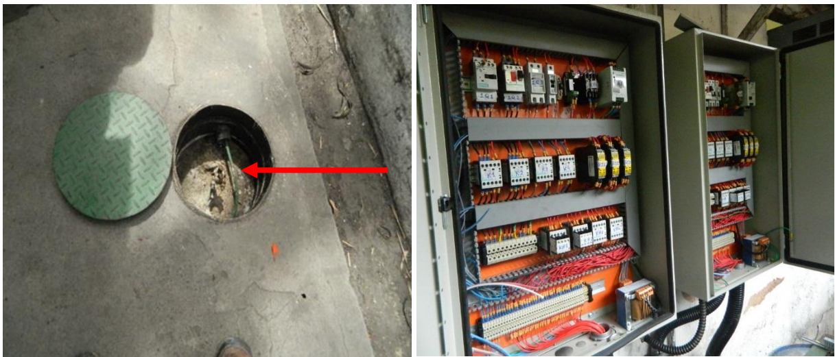
Figuras 9 e 10: Sistema de aterramento e equipotencialização e quadro de comando elétrico. Fonte: Arquivo Pessoal.
