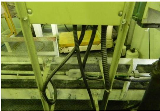
Figura 16– Eletrodutos para acomodar os cabos de força entre o painel e o motor.
