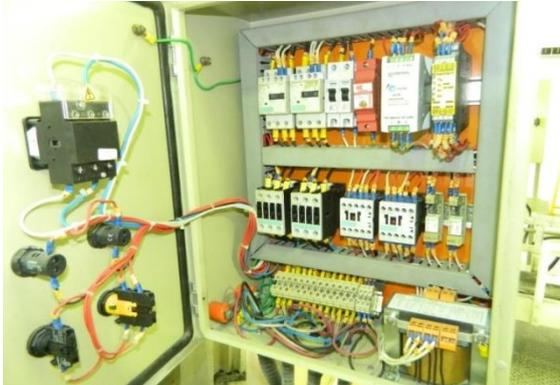
Figura 14– Botões de partida e parada, botão de emergência, botão reset, reles de segurança, comando de partida e parada, chave de segurança c/ bloqueio, contadores auxiliares e disjuntores termomagnéticos
