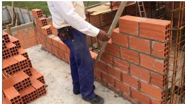
Imagem 01: Execução de Alvenaria
