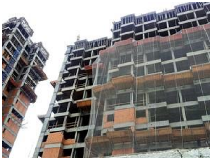
Figura 13. Bandejas primária e secundária, com tela de proteção Fonte: Internet – Marcelo Carvalho / G1 (2019)
